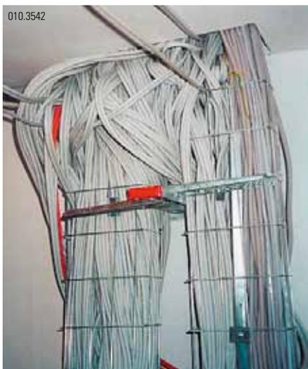
Quand les rayons de courbure sont trop étroits, particulièrement lors de l'installation des câbles, ils peuvent altérer la structure mécanique des paires torsadées du câble et ont ainsi un effet négatif sur les caractéristiques de transmission du dit câble (surtout NEXT, FEXT et RL).
