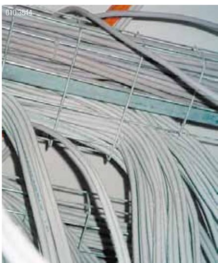
En cas de problème de rayon de courbure sur les câbles posés, de stress subis par les câbles d'installation ou de divers dommages tiers, la validation doit être refusée et un remplacement des câbles recommandé. Les travaux d'installation non conformes tels que coudes, rayons de courbure, tractions ou torsions qui pourraient entraîner des dommages aux câbles sont imputés à la responsabilité de l'installateur.
